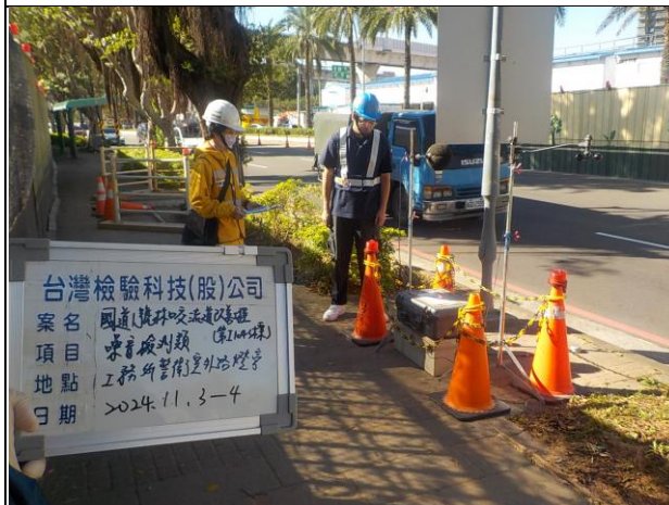
監測項目：環境噪音振動 監測日期：2024.11.03~04 監測地點：工務所警衛室外路燈旁
